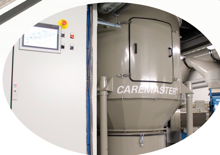
Styringssystem / fjerntilkobling til SCADA
